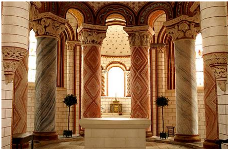
Chœur de Saint-Pierre de Chauvigny (Vienne), première moitié du 12 e siècle
