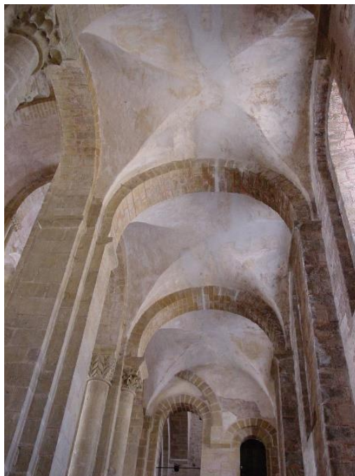
Figure 11 : Voûte d'arêtes. source: Wikipedia
