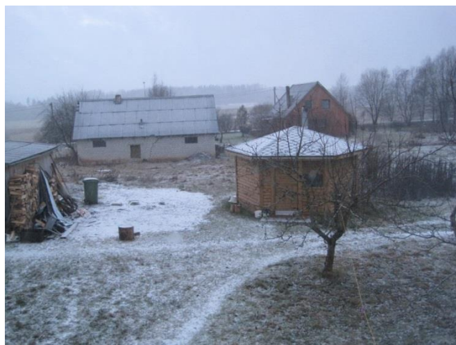
Le pirts, construit par Edgars
